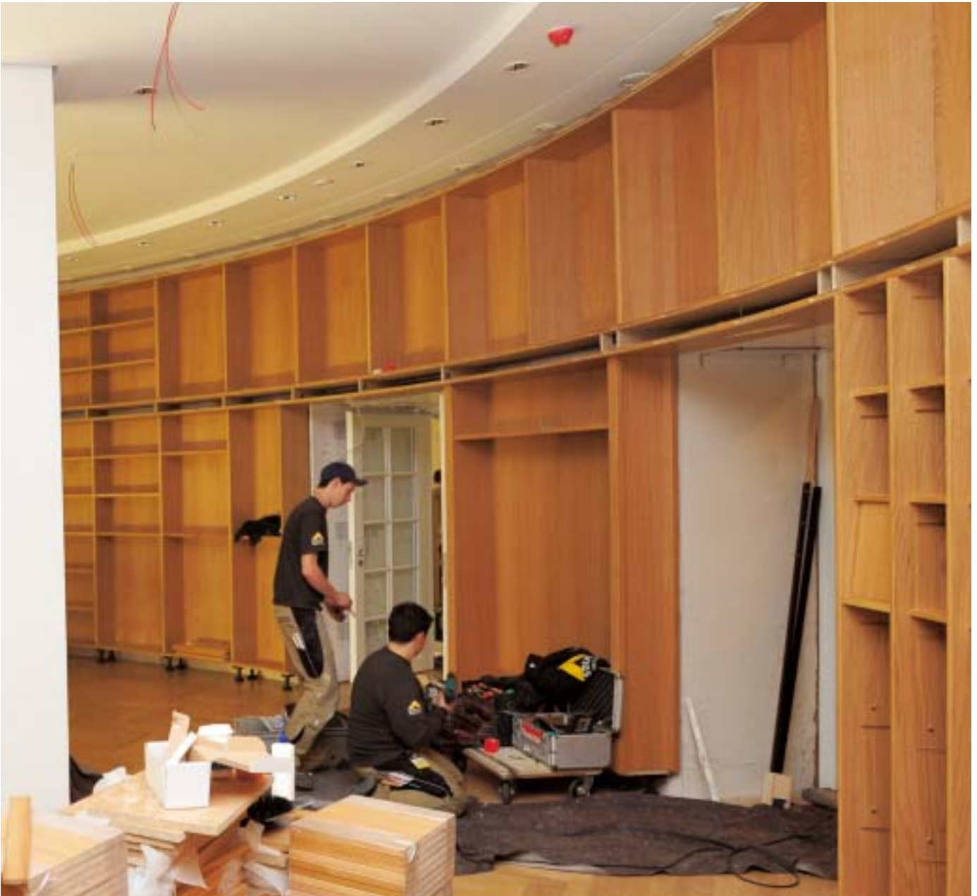
Damit alles passt, war nicht nur bei der Montage die Abstimmung mit Innenausbauern und Elektrikern erforderlich
