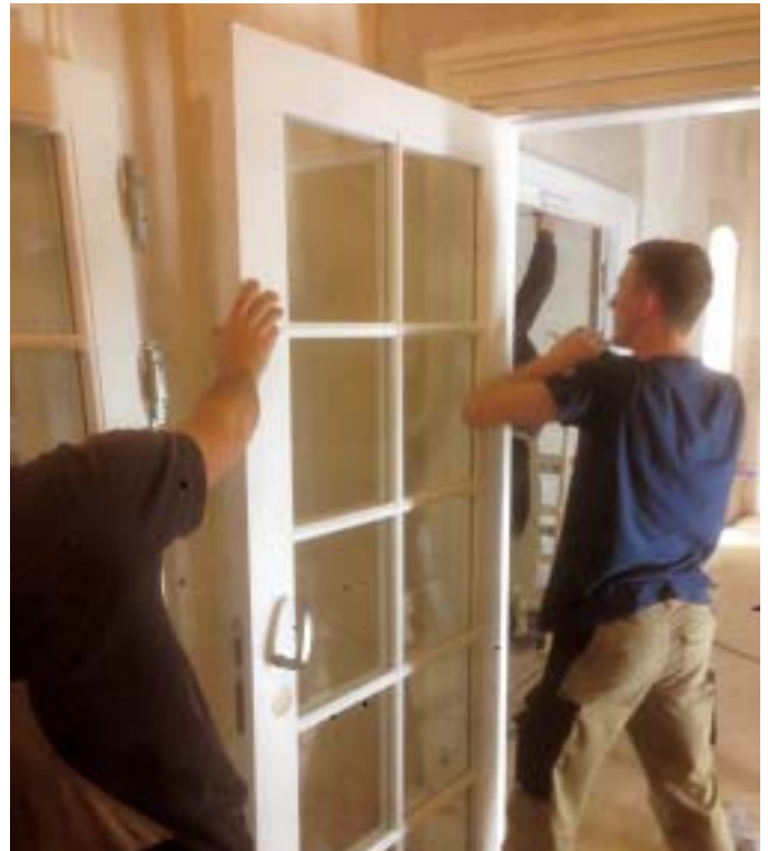
Nummer eins von vier: Montage der fertigen Türen
