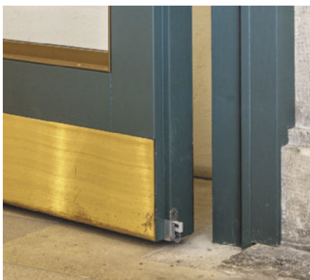
Schutzbleche bronze massiv, Glashalteleisten Stahl, bronzefarben lackiert
