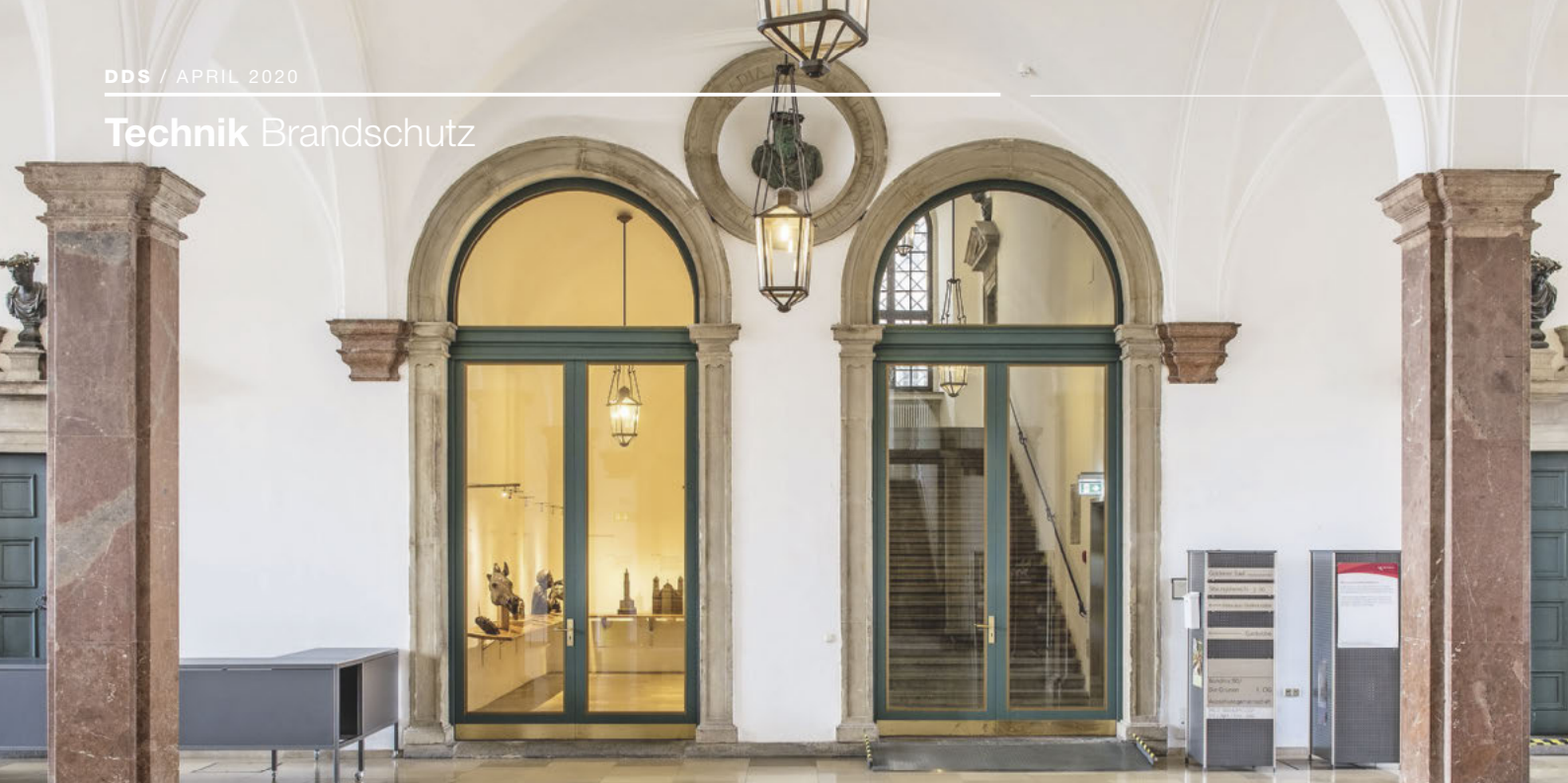
Die Türen sorgen dafür, dass das Treppenhaus im Brandfall rauchfrei bleibt
