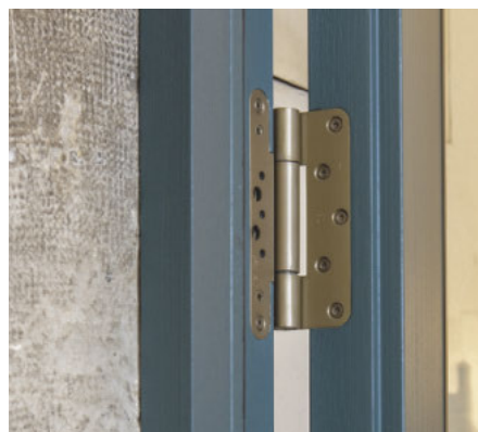
VX-160-3D-Schwerlastbänder von Glutz sorgen für dauerhaft sichere Funktion
